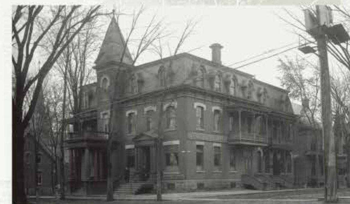
Au croisement de la rue Girouard et de l'avenue du Palais, cet immeuble a abrité plusieurs commerces et institutions financières, comme la Banque d'Hochelaga.
