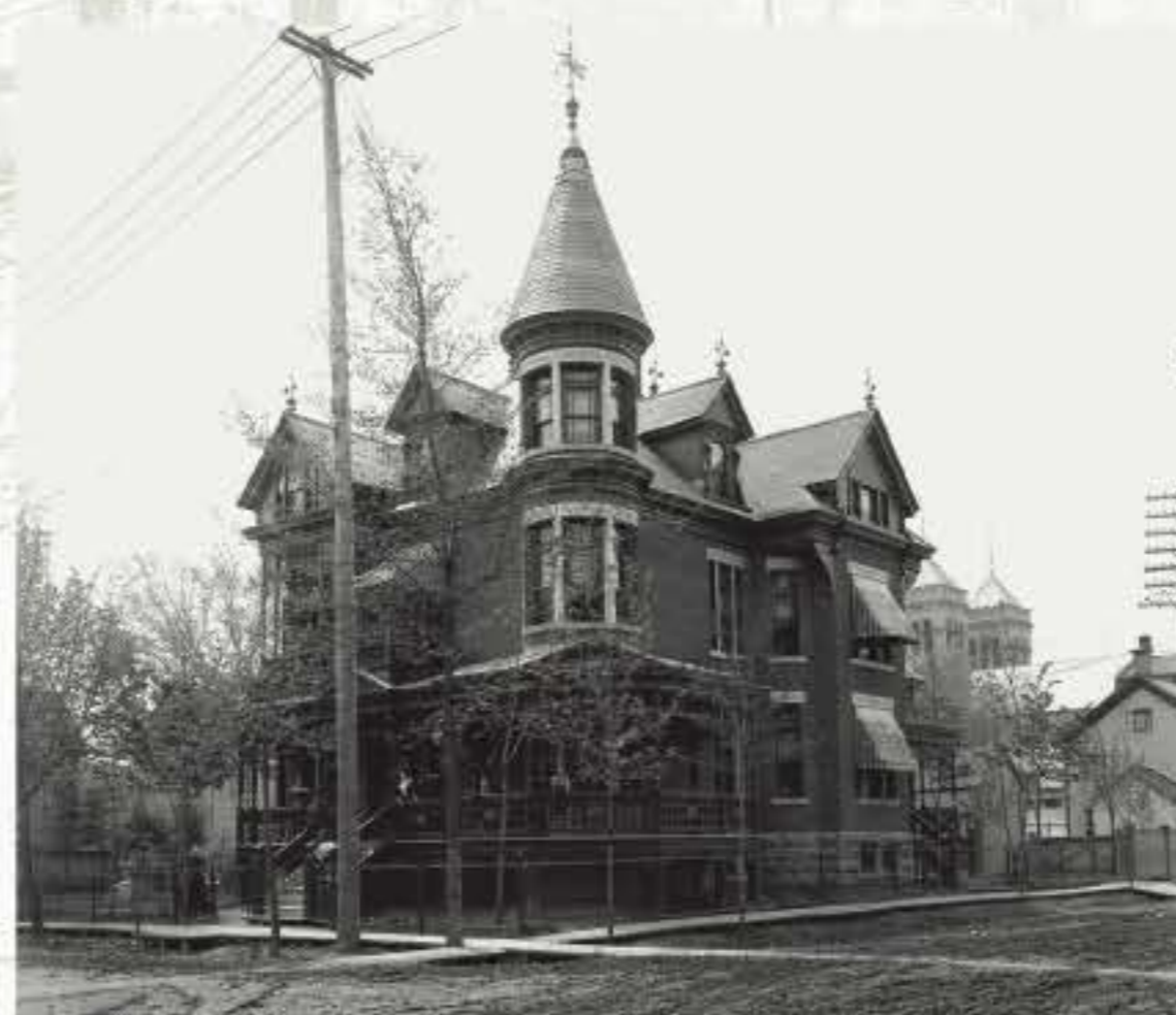
Construite vers 1890, cette maison située à l'angle de la rue Dessaulles et de l'avenue du Palais appartenait à l'industriel Jean-Baptiste Lalime.
